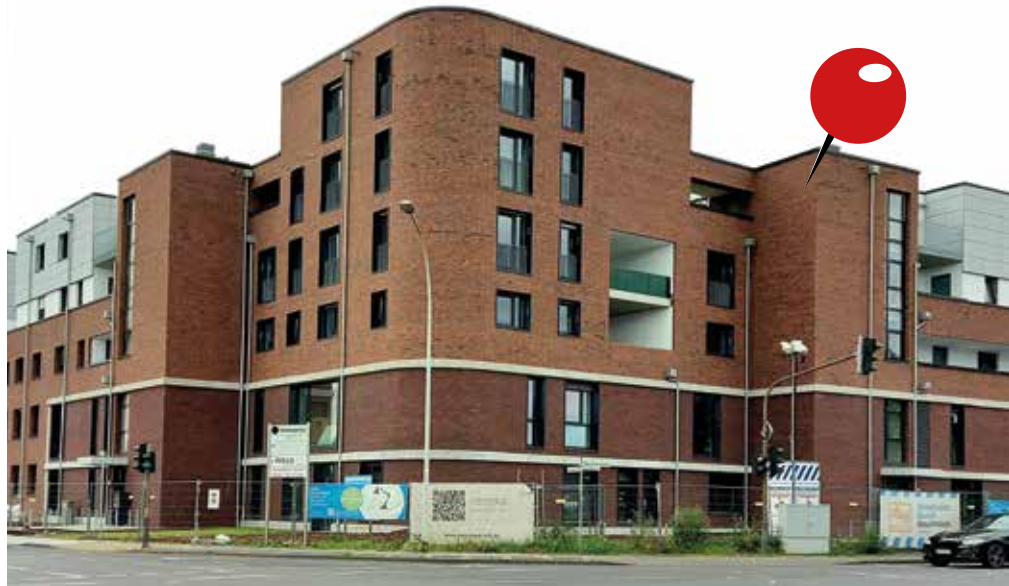
80 neue Wohneinheiten der GWG an der Toni-Ooms-Straße / Alfred-Nobel-Straße
